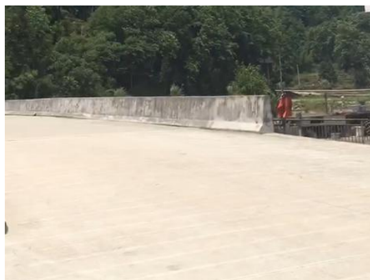
西侧-莒溪大桥
