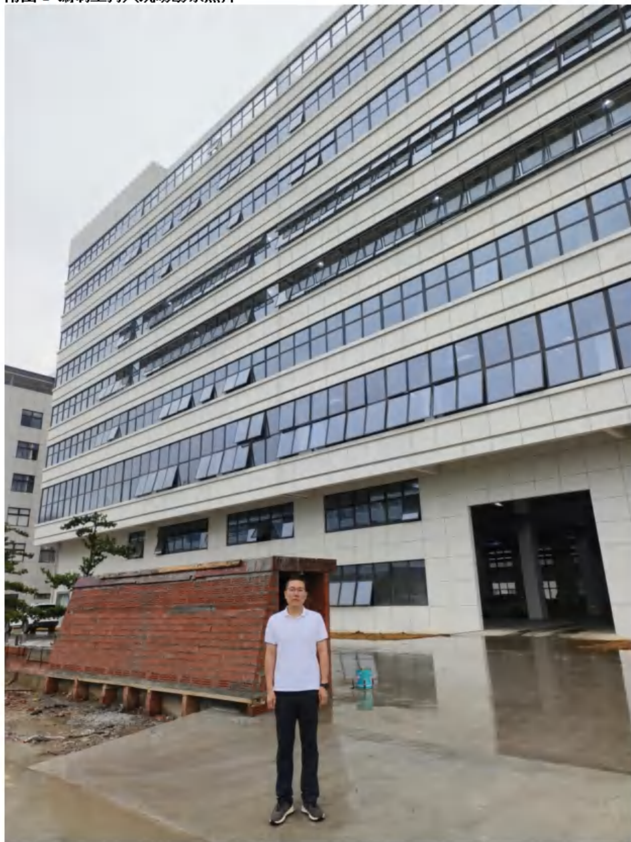
附图 1 编制主持人现场勘察照片
